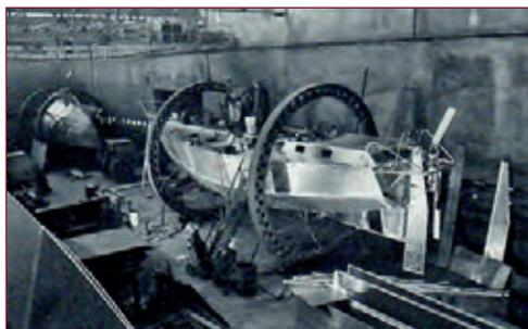
Foto 1.7 Un Dalu 47 realizzato nel 1978. Si notino gli archi per far ruotare le barche e lavorare in piano.
